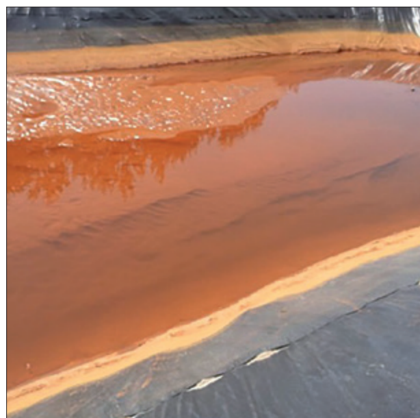
Abb. 1: Entwässerung in Absetzbecken (© Biolog Heppe GmbH)
