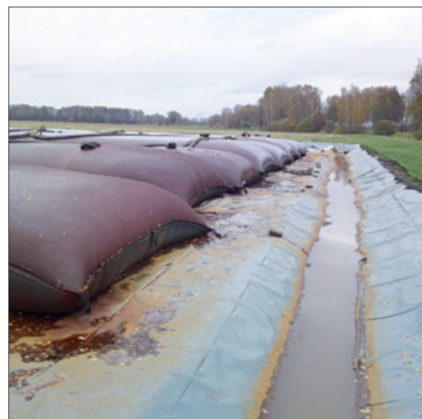
Abb. 2: Entwässerung in geotextilen Schläuchen (© Biolog Heppe GmbH)
