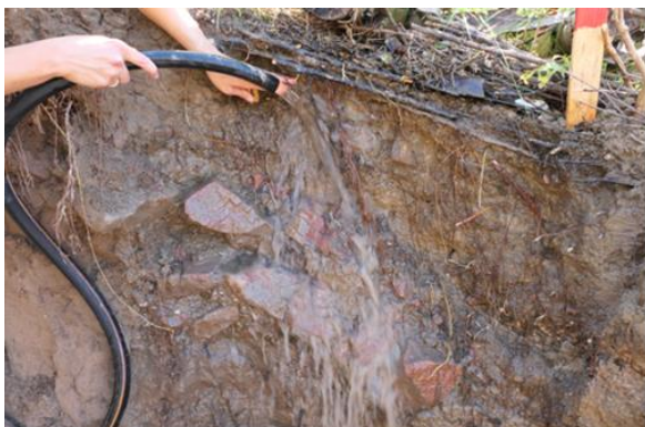
Abbildung 13: Freispülen der Wurzeln im Feld MG1, Untergrund mit alten Wasserbausteinen durchsetzt
