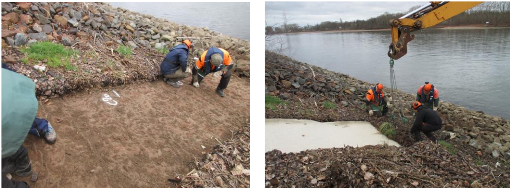
Abbildung 4: links Entnahme der Geotextilproben, rechts Einbau des optimierten Geotextilprototyps „X.2023“ (Fotos: BAW)
