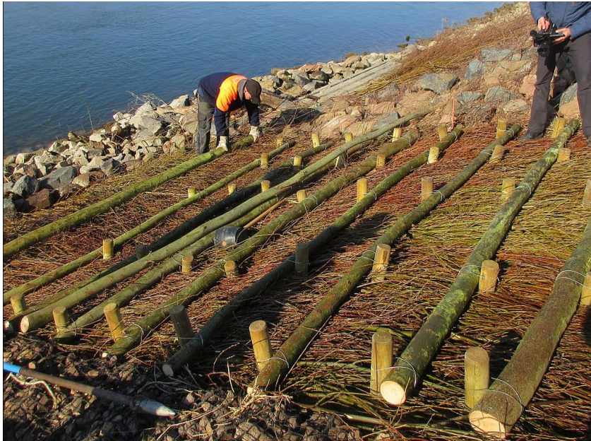
Abbildung 2: Verlegung der Weidenspreitlege
