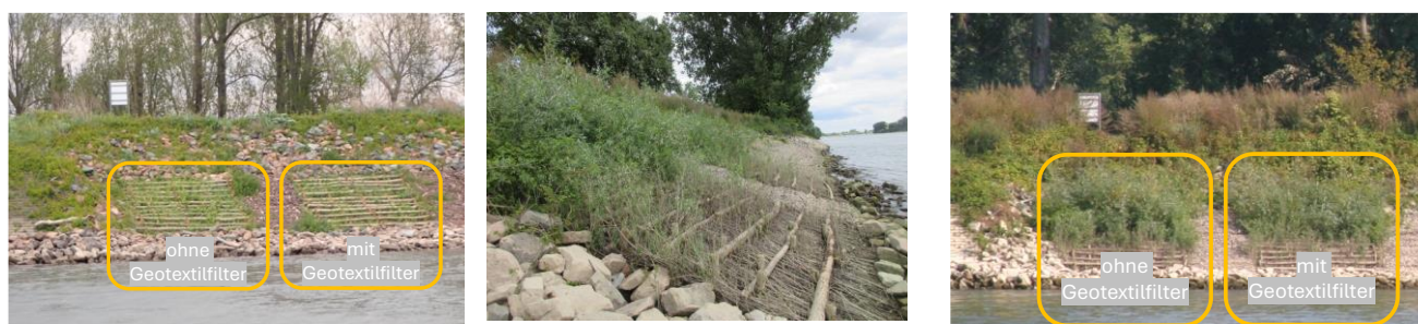
Abbildung 10: Entwicklung der Weidenspreitlagen, links am 4.5.21 (Foto: WSA Oberrhein), mittig am 26.8.2021 (Foto: BAW), rechts am 6.9.2021 (Foto: WSA Oberrhein)
