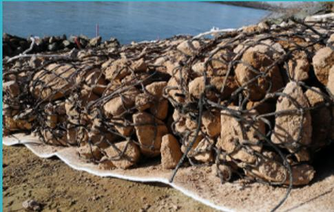
Für die Anwendung in zukunftsorientierten umweltfreundlichen Ufersicherungen an Wasserstraßen: Im Rahmen des Verbundforschungsprojekts »Bioshoreline« werden neuartige biologisch abbaubare Geotextilien aus nachwachsenden Rohstoffen entwickelt.
